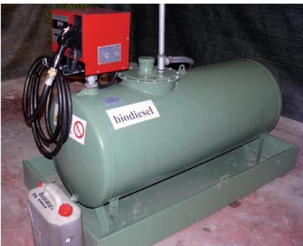
**serbatoio per biodiesel**
